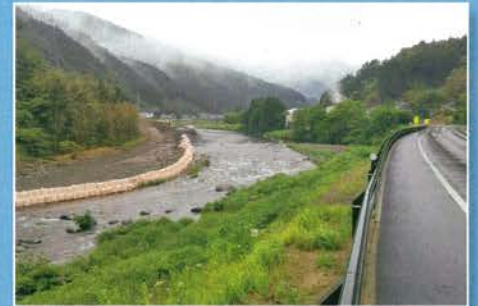
R340 道路改修・河川改修 山谷地区
