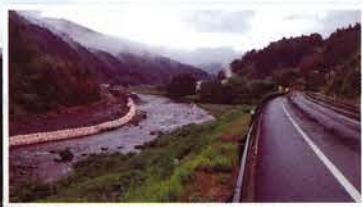
国道340号線 山谷付近 河川改修
