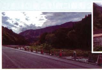
国道340号線 道路改良
