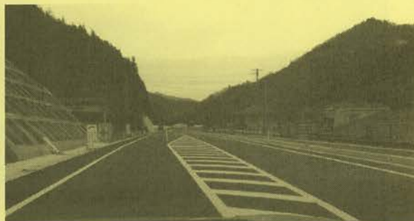
国道340号拡幅改良工事完成
